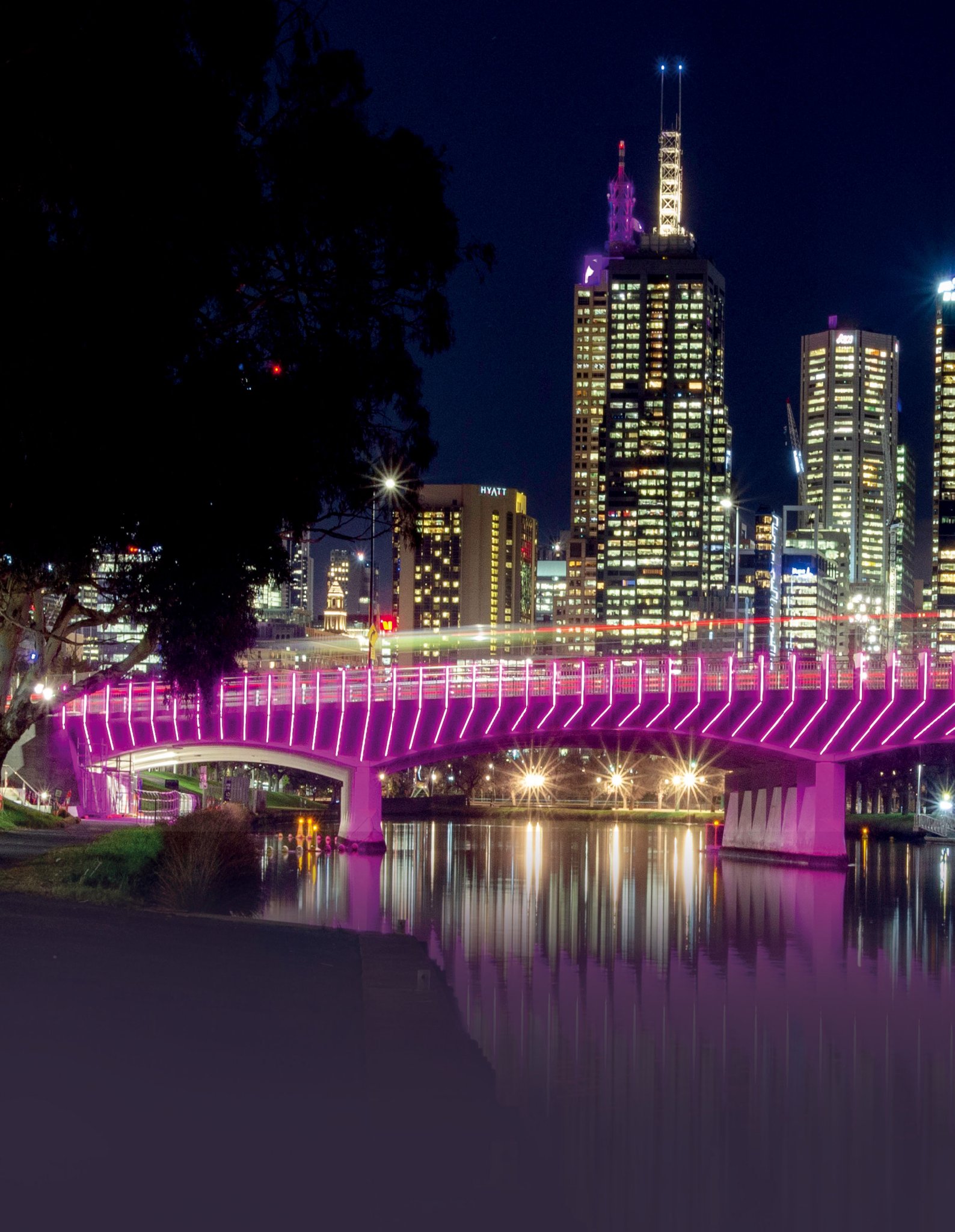
澳大利亚墨尔本市中心街道大桥, 由 Coolon公司设计, BKK公司施工安装
